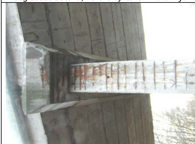
Pohled pod most u pilíře, koroze výztuže sloupů stativ i nosníků KA, odpadávající krytí, mapy
