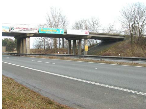
Pohled z boku na most směrem na Mladou Boleslav, čtyřpolová prefabrikovaná konstrukce, reklamy
