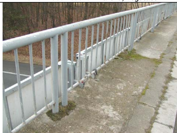
Pohled na římsu a zábradlí, lokální koroze, degradace betonů, vegetace, reklamy
