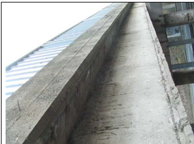
Pohled na bok nosné konstrukce, říms a zábradlí, degradace betonů, koroze výztuže - malé krytí
