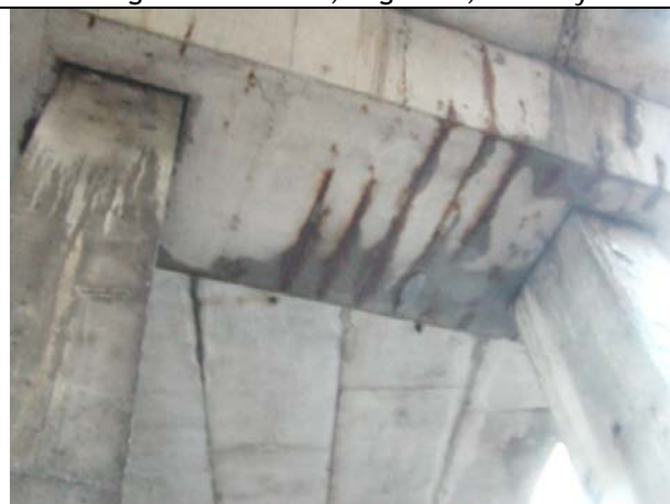
Pohled na standartní stav stativ, masivní zatékání z dilatací, mapy, průsaky, koroze výztuže
