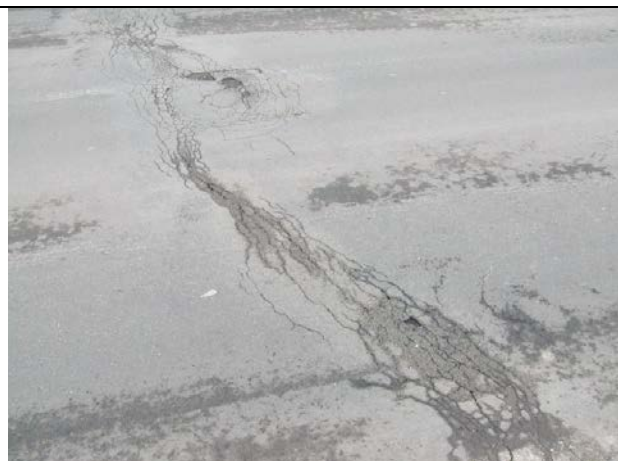
Pohled na dilataci mostu, ostatní 4 dilatace jsou stejné, trhliny, nerovnosti, masivní zatékání
