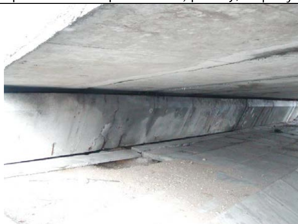
Pohled pod most na opěru, vymletý prostor před opěrami, porušená a chybějící odláždění, mapy
