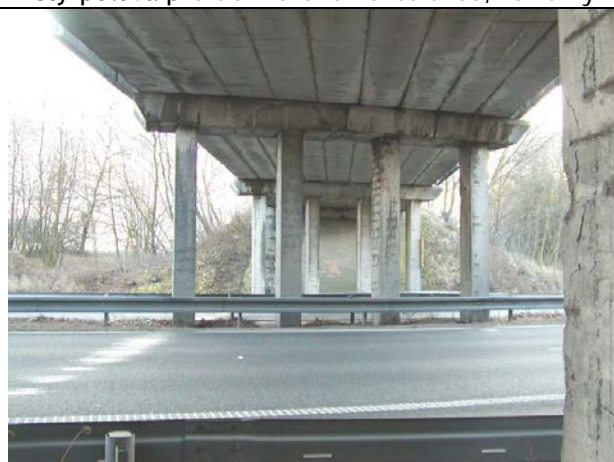
Pohled na spodek nosné konstrukce KA-67 na prefabrikované spodní stavbě, průsaky, krápníky
