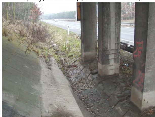
Pohled na odláždění pod mostem u pilíře, příkop podél R10, graffiti, koroze výztuže, vegetace
