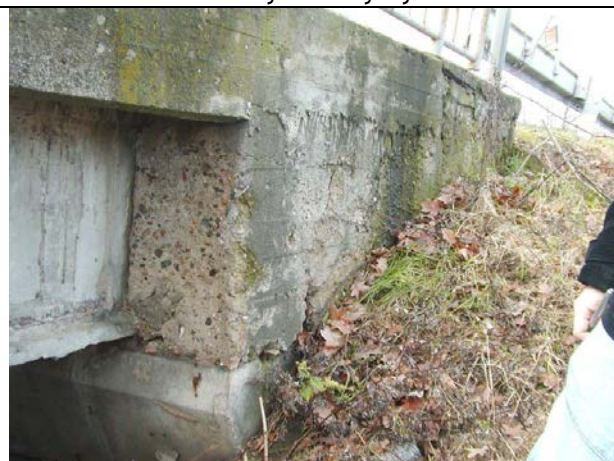
Pohled na jedno z křídel, dobetonovaná část na prefa stativu, degradace betonu, lišeje, mapy
