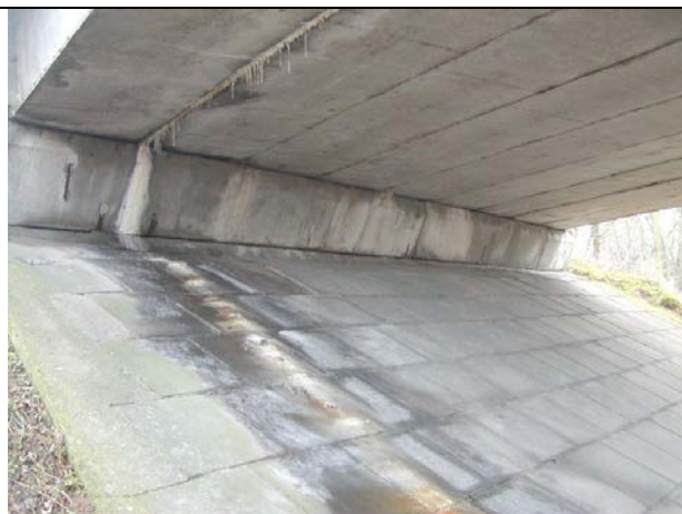
Pohled na průsaky podél krajních nosníků, výluhy, krápníky, mokré mapy bílé a hnědé barvy
